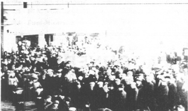
Rassemblement sur la rue St-Louis face au magasin J.A. Savoie.
