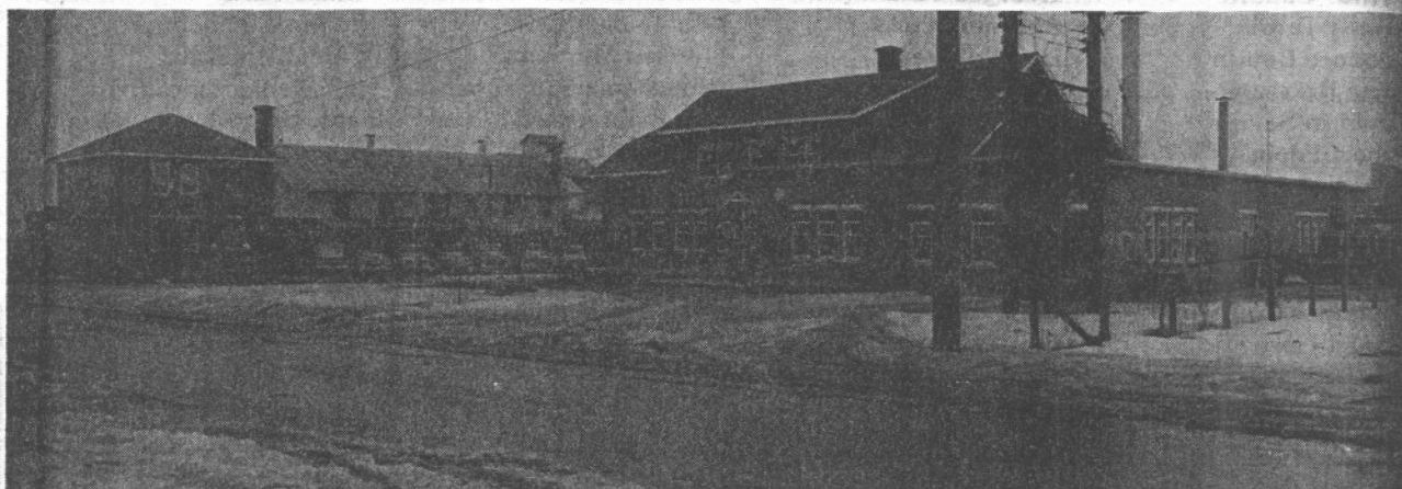
À gauche, le bureau construit à l'automne 1945. En arrière-plan, la meunerie construite en 1941. À l'extrême-droite, l'usine laitière (beurre, fromage, lait en poudre-caséine) bâtie en 1945 et agrandie en 1947.
