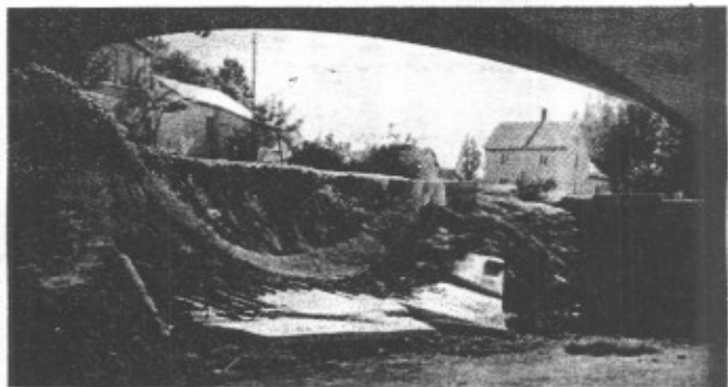
Mur de soutènement du pont Simoneau arraché par la crue.
