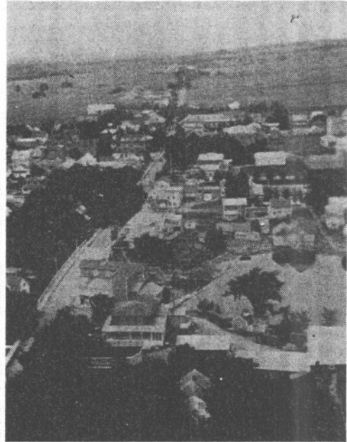
Partie Est de la rue St-Calixte vers 1930. À noter, la nouvelle meunerie près du nouveau pont Simoneau. Le barrage, propriété de la ville, a été refait en béton en 1928. À remarquer la bâtisse de la glacière avec sa rampe de montée pour les blocs de glace.
