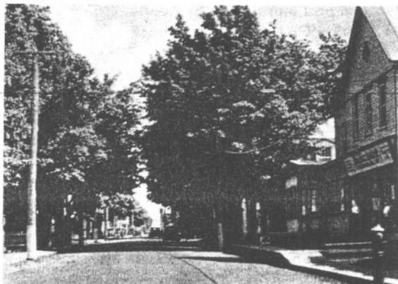
L'avenue St-Louis en 1931, avait un caractère plutôt résidentiel avec ses beaux érables. Le centre du chemin était en macadam goudronné et, les côtés en gravier. À droite, à la place de cette résidence, c'est le magasin de la Société des Alcools du Québec, et le magasin Painchaud.
