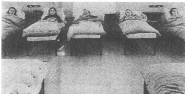
Sanatorium au 5e étage. En 1928, 30 tuberculeuses y prennent place avec solarium permettant une cure d'air. En 1938 s'ajoute le préventorium au 3e étage.
