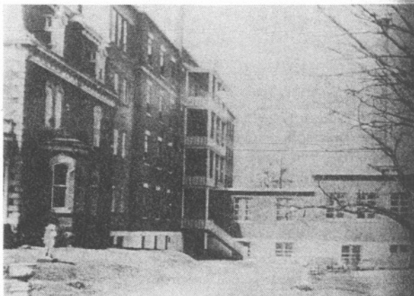
1948: Construction d'une annexe de 100 par 150 pieds pour une chaufferie et une buanderie.
