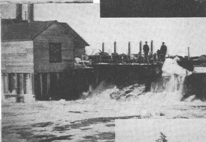
Barrage de la Compagnie électrique de Somerset sur la rivière Blanche.
