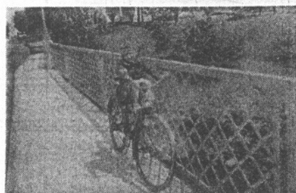
Rampe métallique du pont de la rue Savoie.
