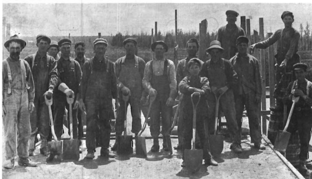
Construction du pont de fer
