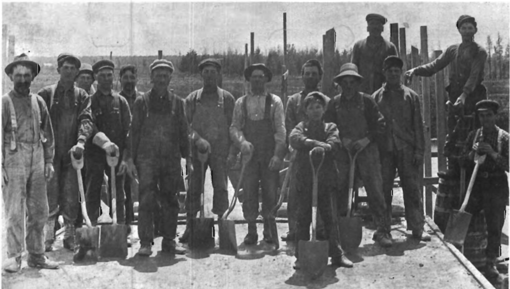
Construction du pont de fer
