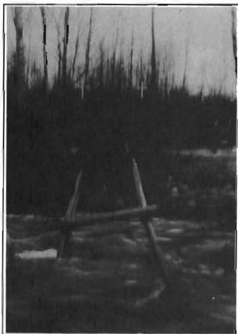
Construction du 1 er pont de la grotte
