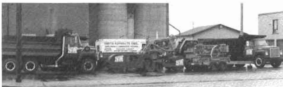
Machinerie Smith Asphalte Enr. Prop: Gilbert Smith
