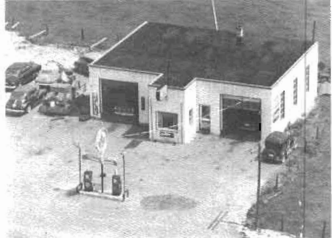
Vue du garage en 1950
