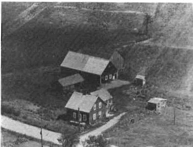
La ferme Martin (Bâtisses aujourd'hui inexistantes, sauf pour la maison qui a été rénovée et déménagée)
