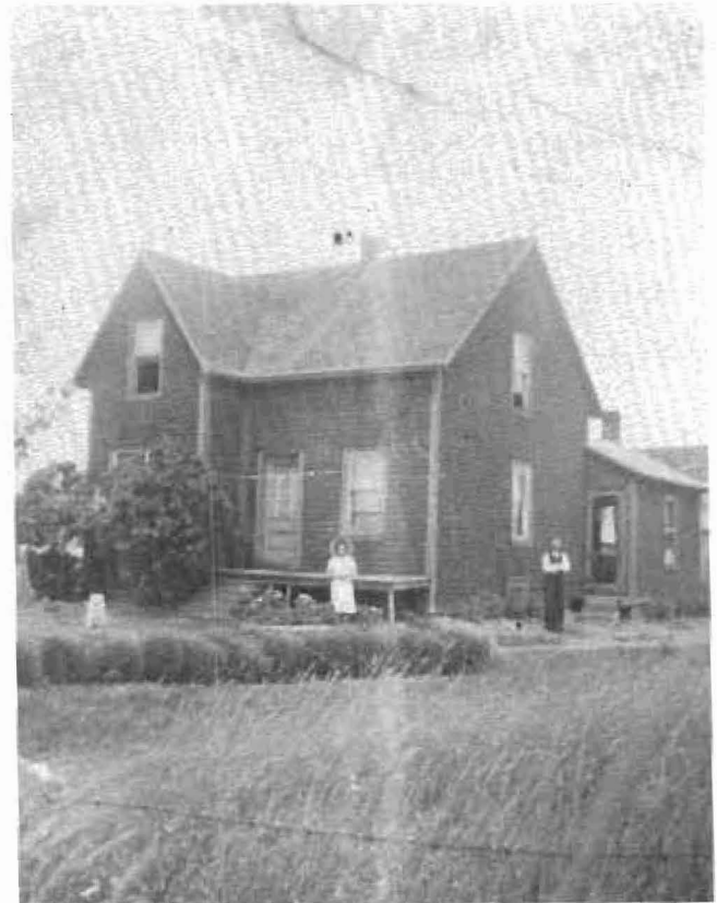
La première maison qu'Éphrem a construite à Bon-Conseil
