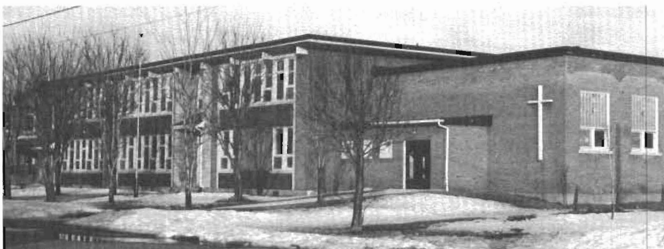
Façade de l'École Centrale sise au 500 rue St-Bruno, érigée en 1960
