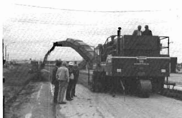
Sintra 1982, Planage de chaussée (Princeville)
