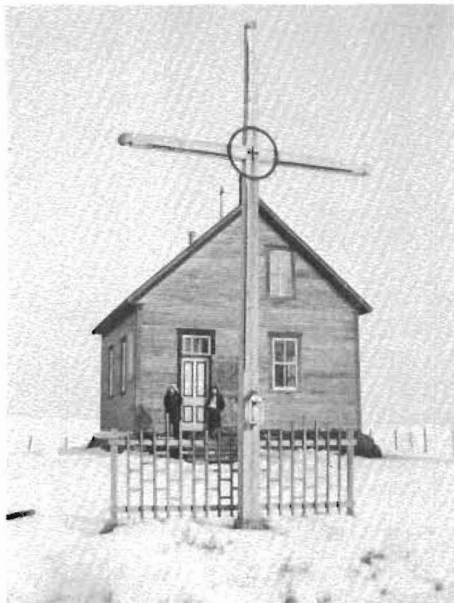
Vue d'une école typique de ce temps (Rang de la Rivière)
