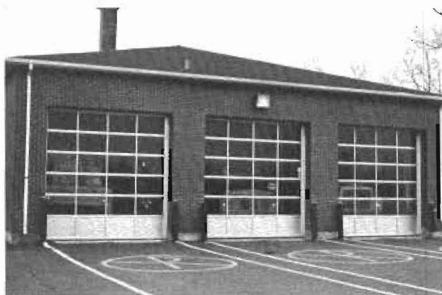
Poste d'incendie aujourd'hui
