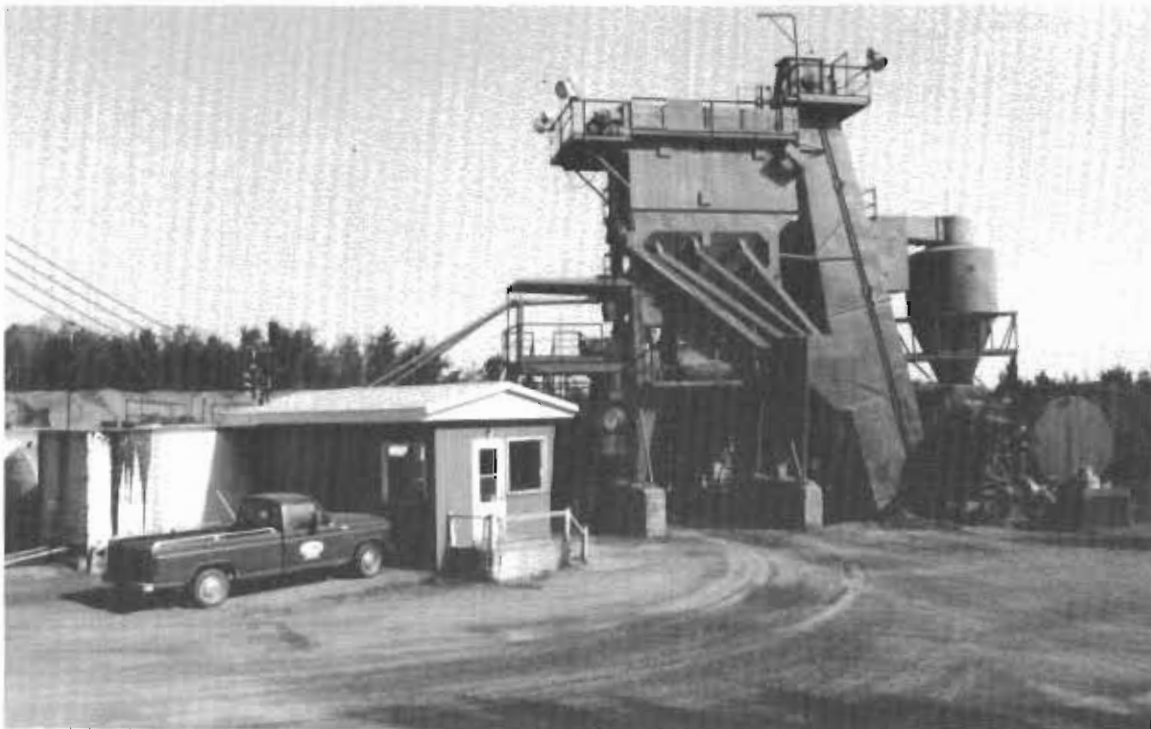
Le plan d'asphalte Lacbec, usine de Durham-Sud. 1987 Lacbec
