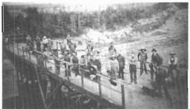
Rampe de chargement des wagons qui se faisait à l'aide de brouettes Wagons loaded by wheelbarrels
