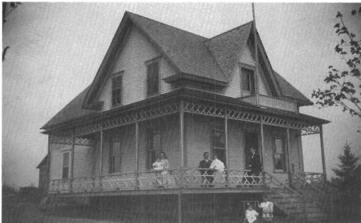
Maison familiale construite en 1903 par Jean-Baptiste
