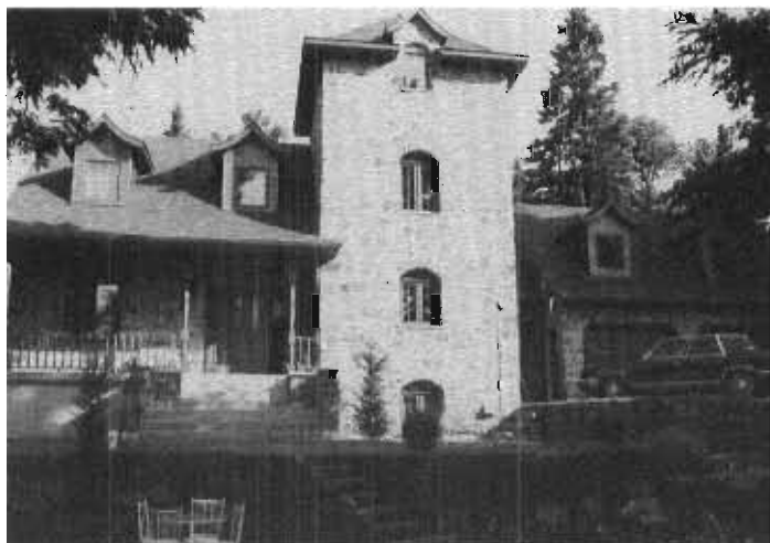
Maison à Chatham
