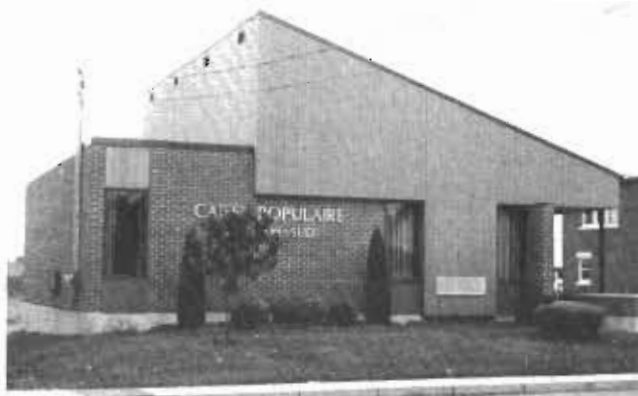
Édifice actuel de la Caisse depuis 1978 Present location of the Caisse
