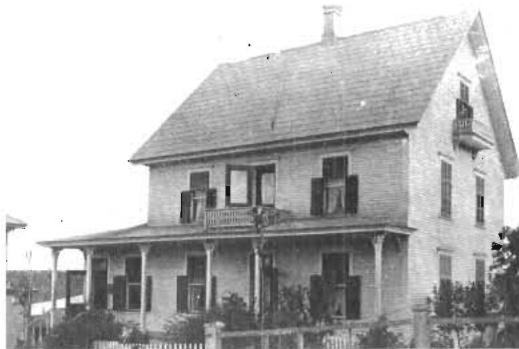
Bureau de poste South Durham, Résidence Préfontaine. 1900-1964 South Durham Post Office
