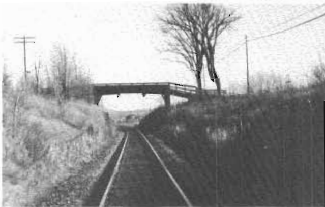
Pont traversant la voie ferrée, chemin Mooney et route 116 Overhead bridge Mooney road and Route 116
