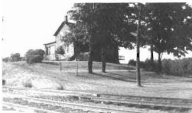
Maison du chef de gare Station agent's house
