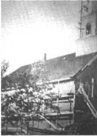
Rénovations église Saint-Fulgence Church renovations 1925
