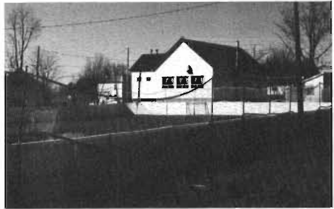
Salle des Loisirs 1987 Recreation Center
