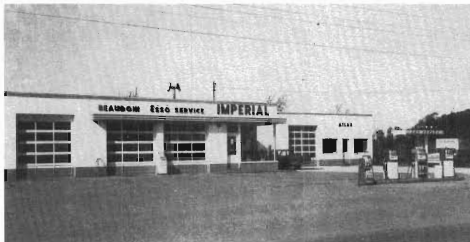
Garage construit en 1957 sur la route 116
