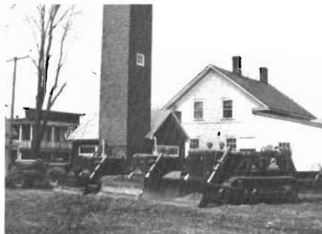
Première caserne construite en 1947 avec tour pour séchage des boyaux First fire station with the hose drying tower
