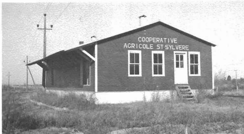
Entrepôt de patates, loué à Aston-Jonction
