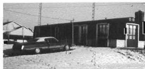
Maison mobile familiale que Bruno installe lui-même sur un solage en 1974
