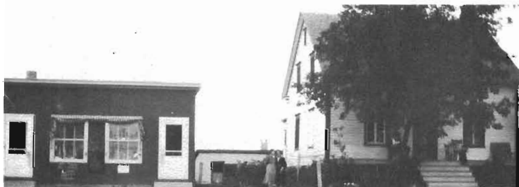
Magasin construit en 1932. Épicerie, cordonnerie, chaussures pour tous. À côté: maison familiale au 779, 12 e rang
