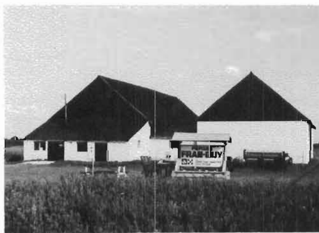
Grange-étable rénovée en 1985
