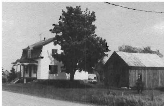
Maison construite par Faïda Morel au 8 e rang
