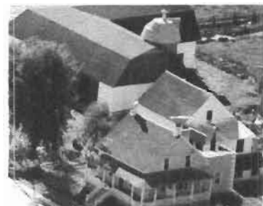
Grange-étable construite en 1946-47, maison rénovée en 1953
