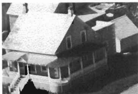
La maison rénovée
