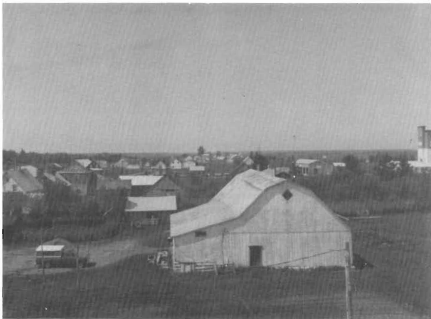
Vue de l'ouest de la paroisse avec la meunerie coopérative à droite.
