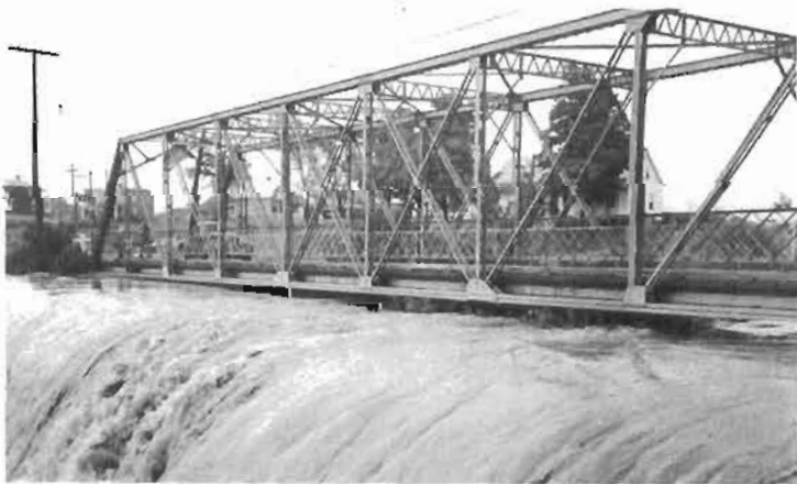
Le pont sur la rivière des Pins en période de crue.
