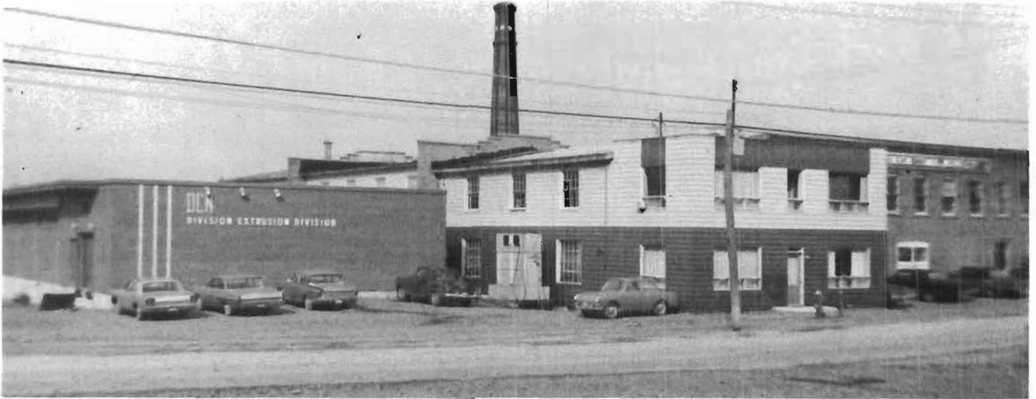
Les Installations de la Dominion Comb en 1974.
