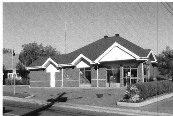
Bureau de poste actuel.
