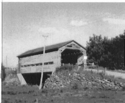
Le pont Gagné dit le pont du 5e rang.
