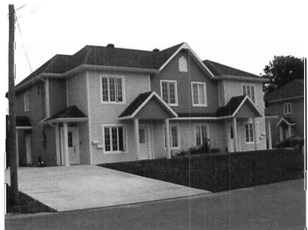
Immeuble 4 logements, Construction C. G. Bissonnette Inc.
