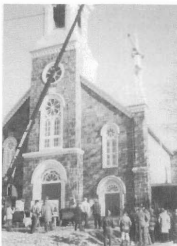
Les cloches sont réparées et réinstallées...
