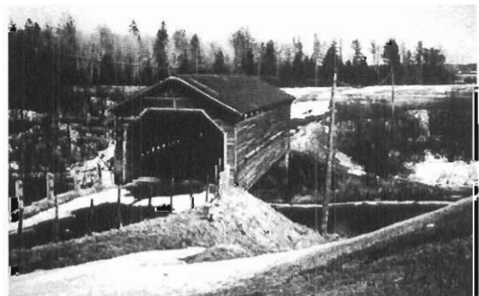
Le pont Perrault dit le pont du 2e rang.
