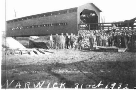
Le pont Lainesse dit le pont du 4e rang.
