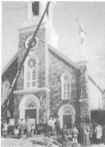
Les cloches sont réparées et réinstallées...
