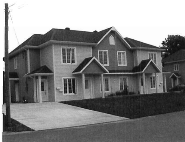
Immeuble 4 logements, Construction C. G. Bissonnette Inc.
