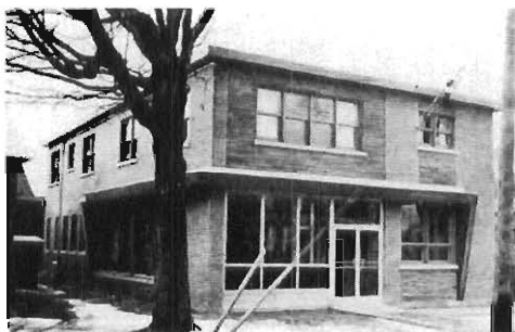
Deuxième site de la Caisse, rue Hôtel-de-Ville.
