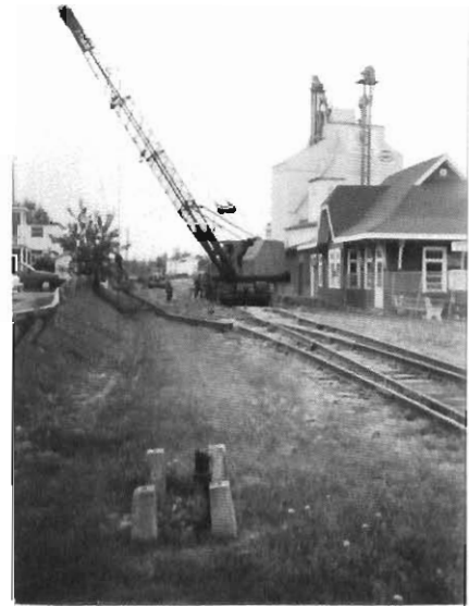
Démolition de la voie ferrée à Warwick, en 1990.
