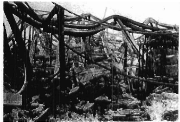
Tout n'est plus que cendres et fer tordu par la chaleur.
