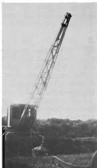
La pelle à «steam» qui creusa la rivière à «Pat» en 1932.
