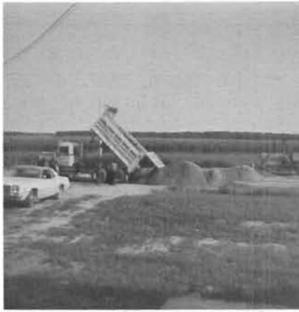
Construction de la forme de chemin en 1980.
