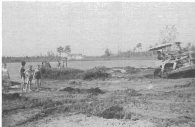
Un « bulldozer » tirant un îlot de mousse lors du développement du Lac-des-Cyprès.
