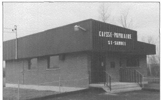
Le bâtiment de notre Caisse bâtie en 1979
