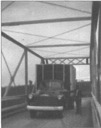
Richard Bergeron et son premier camion en 1954, posé sur l'ancien pont de bois
