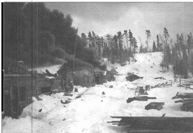
Camp de bûcherons vers 1948 à Val d'Or. Après la saison, on mettait le feu dans les camps car on avait terminé ce chantier et ça donnait rien de laisser les camps construits
