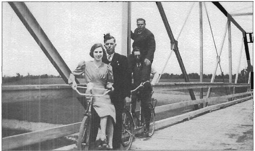
En vélo sur le vieux pont. Ici on observe bien une bonne partie de la structure du pont de fer. Justine Martin, Philippe Lampron, Maurice Cyrenne et, sur Maurice, Germain Martin
