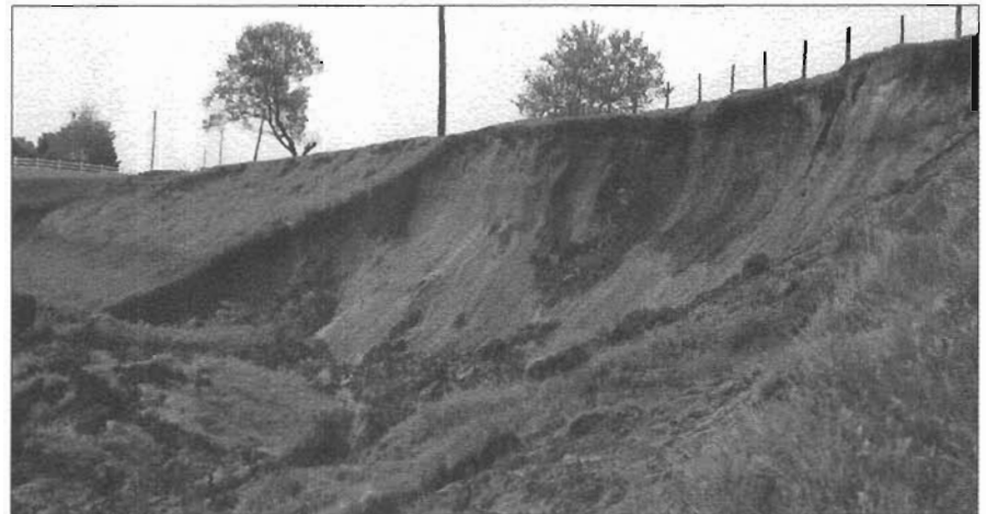
Éboulis devant la résidence de Jacques Bergeron. Une bonne partie du chemin s'est retrouvée à la rivière, vers 1990.
