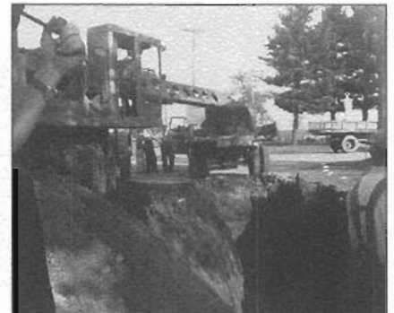
On s'affaire à installer les égouts devant l'église
