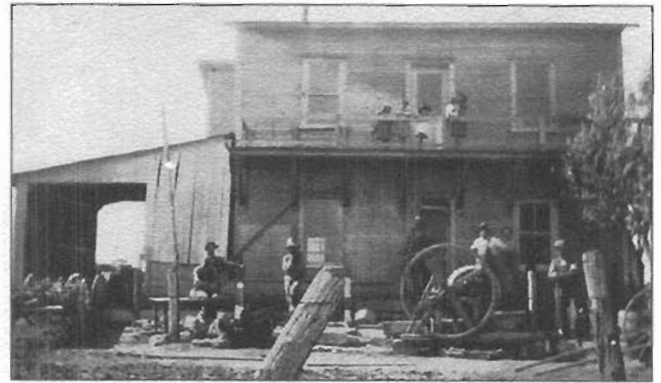
On cimente le plancher de la fabrique de beurre du rang 4. Mixer à ciment fabriqué avec une roue de Hasford. Vers 1920
