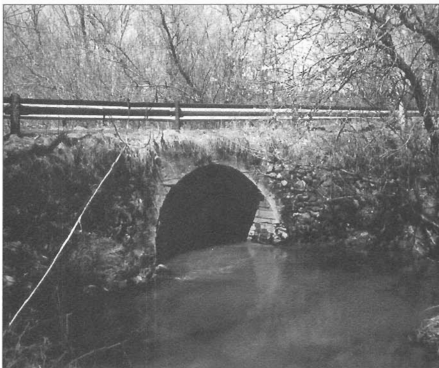
Le pont de la route à Rivard
