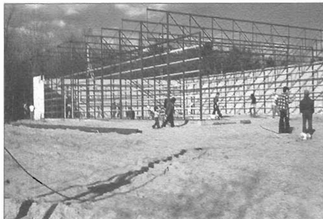
Élévation de la structure d'acier
