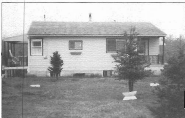
Chalet avant les rénovations
