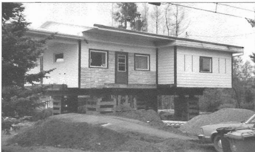
Les rénovations commencent... juillet 2001
