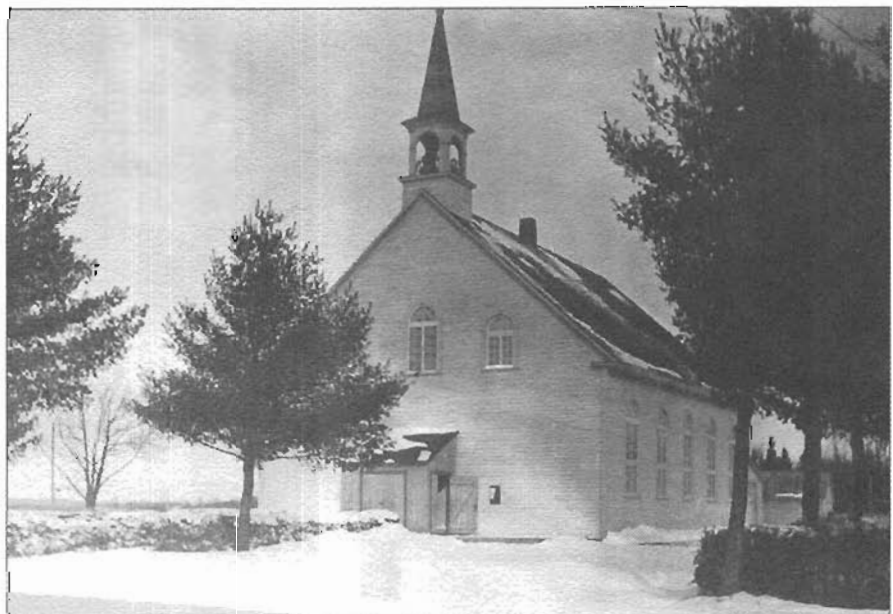
L'église dans les années 1920, la sacristie est derrière l'église
