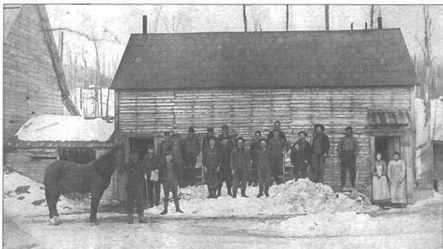
Gars de chantier à Witherivers vers 1905. Ovila Béliveau avait 15 ans. Remarquez le dernier homme à la droite, on dirait bien qu'il est accroché au mur à deux pieds au-dessus du sol
