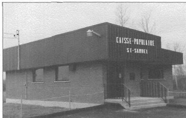
Le bâtiment de notre Caisse bâtie en 1979
