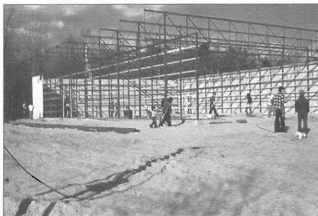
Élévation de la structure d'acier
