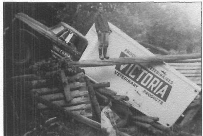
Oups! Ça à l'air que le pont n'était pas assez solide. M. Lampron livrait des vitamines en passant sur un pont avec son camion vers 1965 en Ontario
