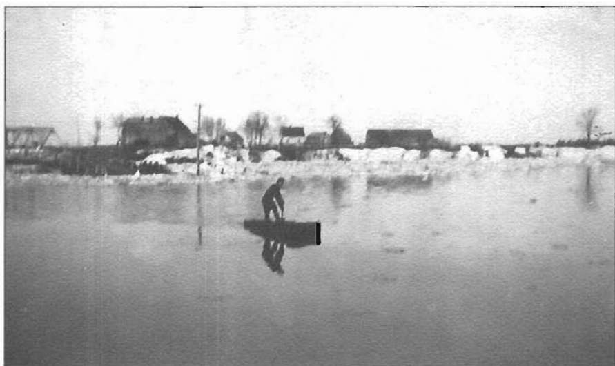
L'eau est trop haute, il faut traverser en chaloupe ou en bac. On voit une partie du pont de fer, la fromagerie à droite.
