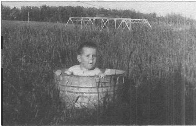
Serge Lampron assis dans la bassine. Derrière lui, la structure supérieure du pont de fer monte au-dessus de l'herbe.
