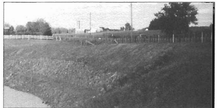
Les travaux terminés du remblaiement de la rivière du rang 3 vers 1990
