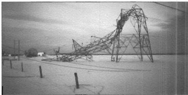
Les pylônes du rang 3
