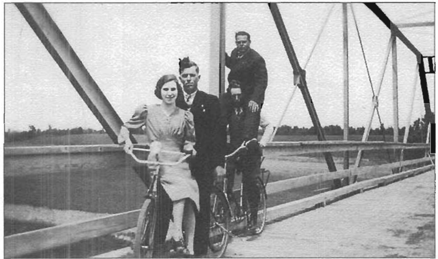
En vélo sur le vieux pont. Ici on observe bien une bonne partie de la structure du pont de fer. Justine Martin, Philippe Lampron, Maurice Cyrenne et, sur Maurice, Germain Martin
