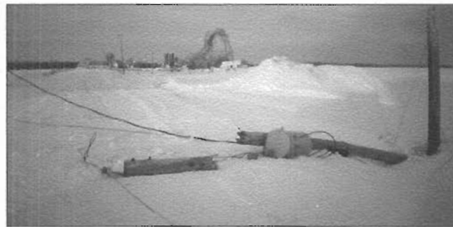
Les poteaux d'électricité n'y échappent pas non plus au rang 3!
