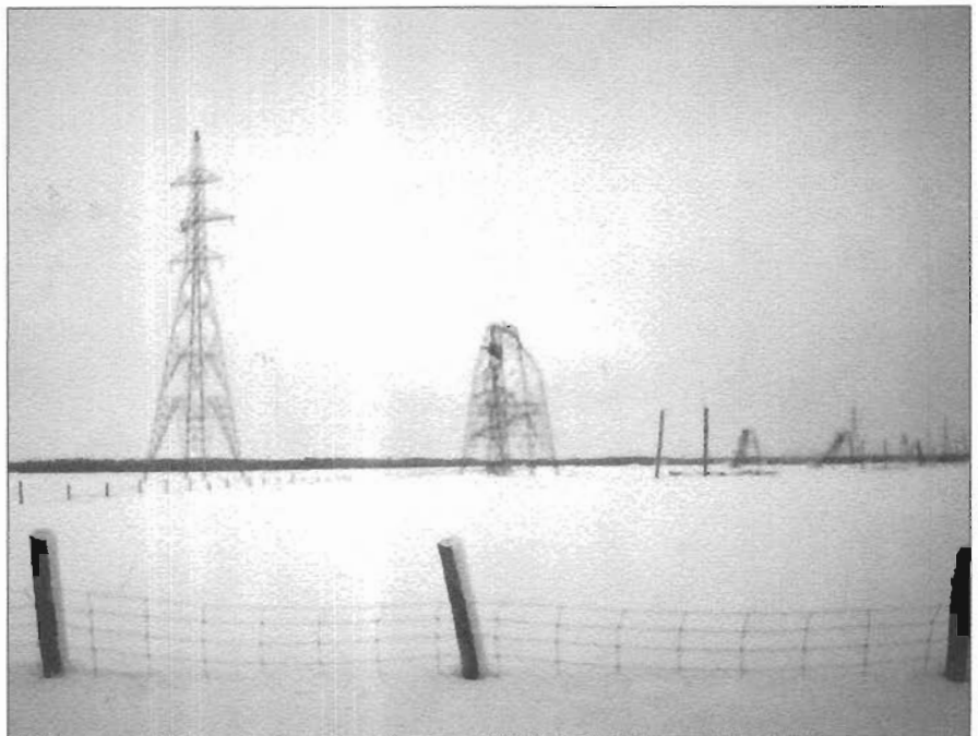
Trois lignes électriques touchées au rang 3 vers le 4
