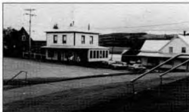
La maison que Georges a bâtie en 1920
