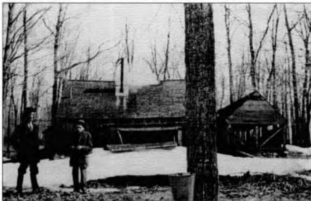
L'ancien pont de cabane facilitait de beaucoup le transvasement de l'eau d'érable du tonneau au "bac"
