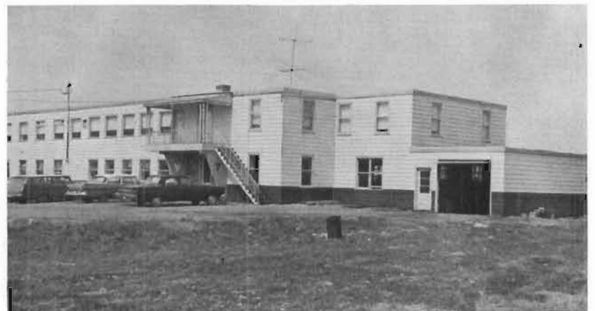
Après les rénovations.
