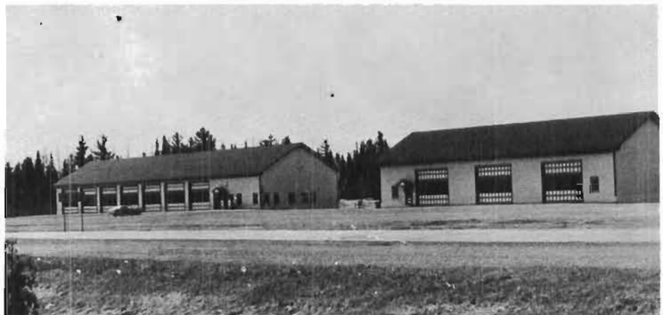
Le garage de la voirie, construit en 1964.
