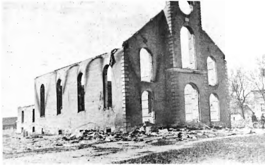
Les restes de l'église après l'incendie de 1915.
