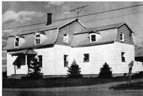
Maison de Lucien Trépanier
