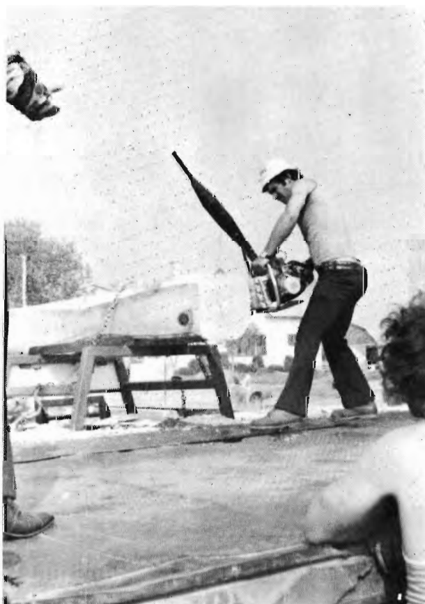
Avec ce genre de scie, vous faites trois coupes dans un billot de 14 x 14 pouces, en 10 secondes.
