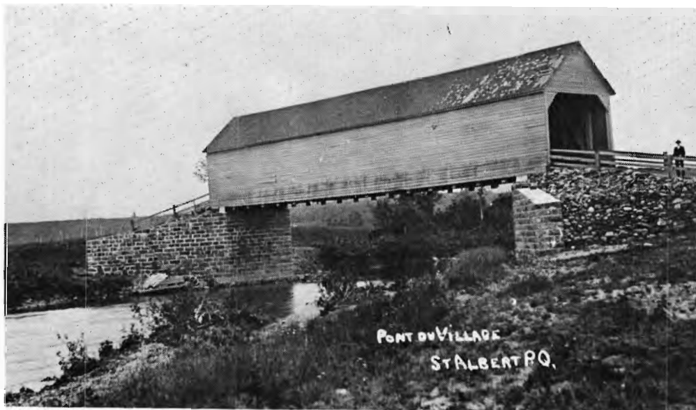
Pont du village de Saint-Albert.
