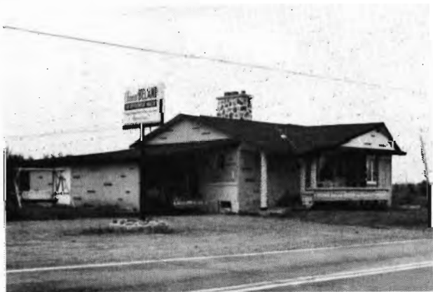
Clément Béland, entrepreneur en maçonnerie.
