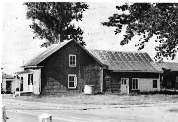
La boulangerie de M. Ludger Guillemette était dans la partie arrière, à l'extrême droite.
