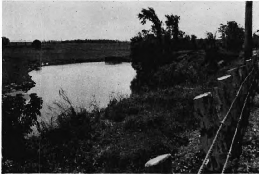
Le lit de la rivière s'est déplacé vers la droite. Elle mine la côte à certains endroits.
