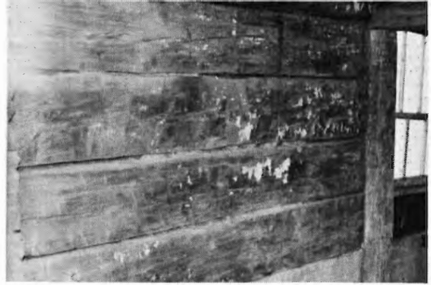
Intérieur de cette maison. Remarquons les murs en pièces équarries à la hache.
