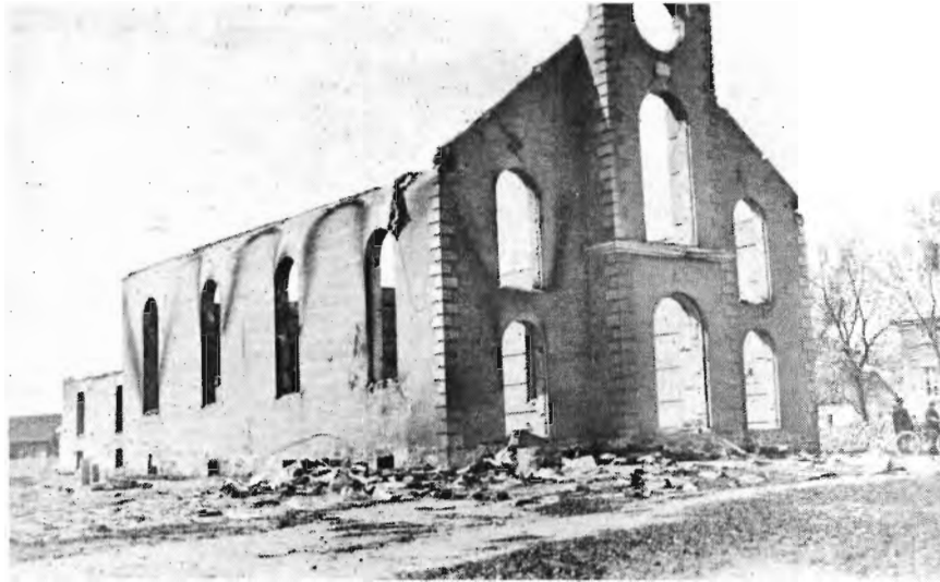
Les restes de l'église après l'incendie de 1915.
