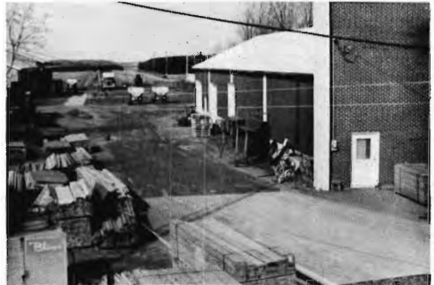
Entrepôt et cour du magasin Ducharme
