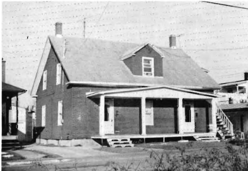
Premier presbytère de Saint-Albert, sur la rue Héon, à Victoriaville.
