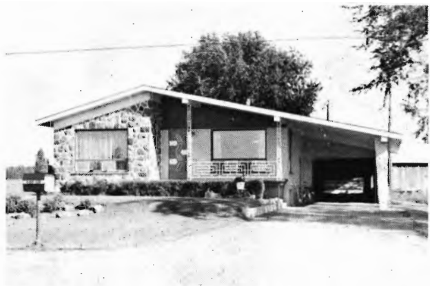
Maison de Maurice Bussière
