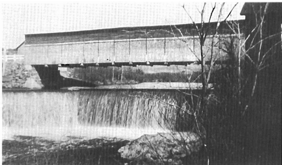
Pont couvert du rang 1 et la chaussée.
