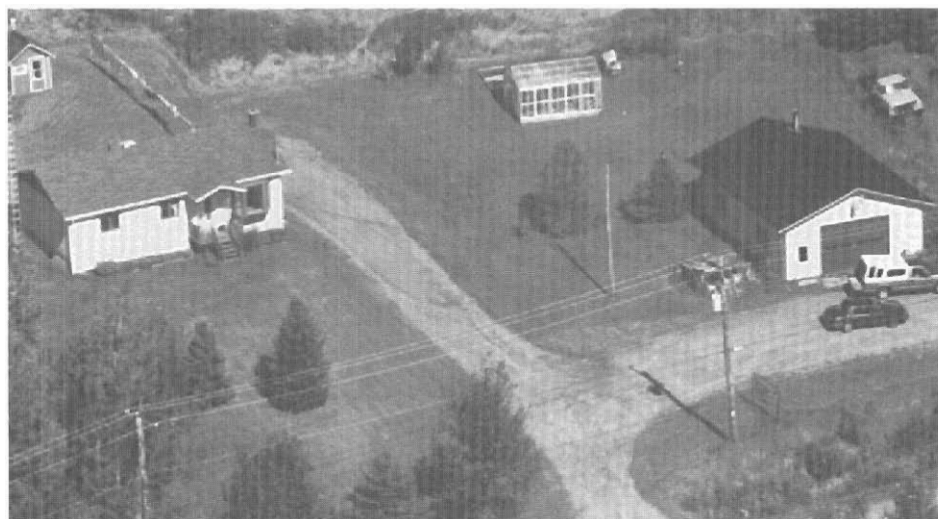
La maison et le garage.
