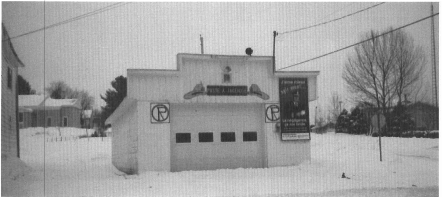
Poste à incendie.
