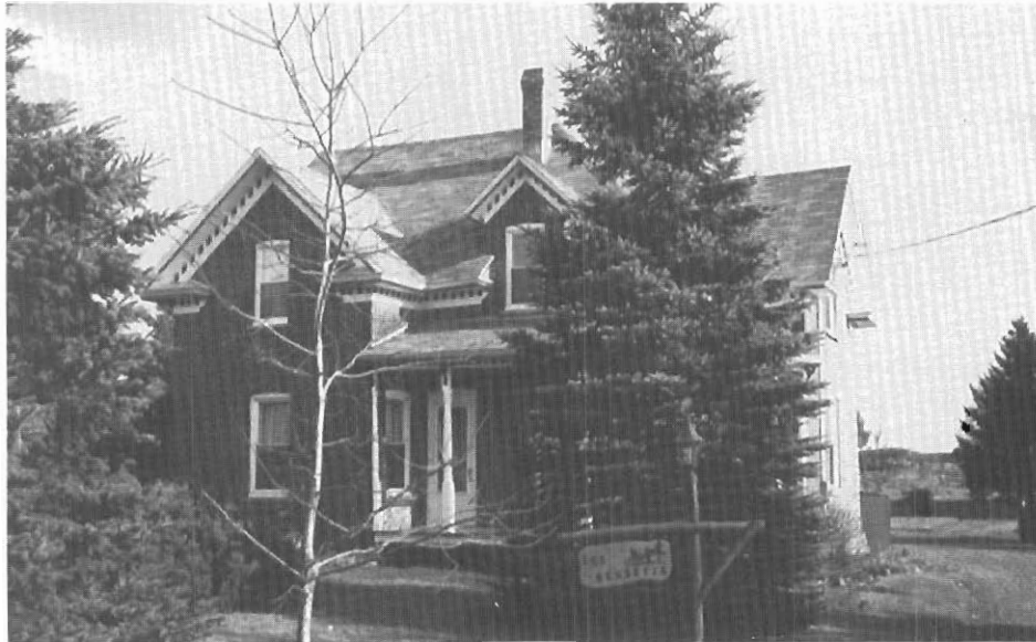
MAISON DES BESSETTE (1995), telle que rénovée, avec ses arbres. Remarquez la cheminée neuve (1994) et le toit (1989).
