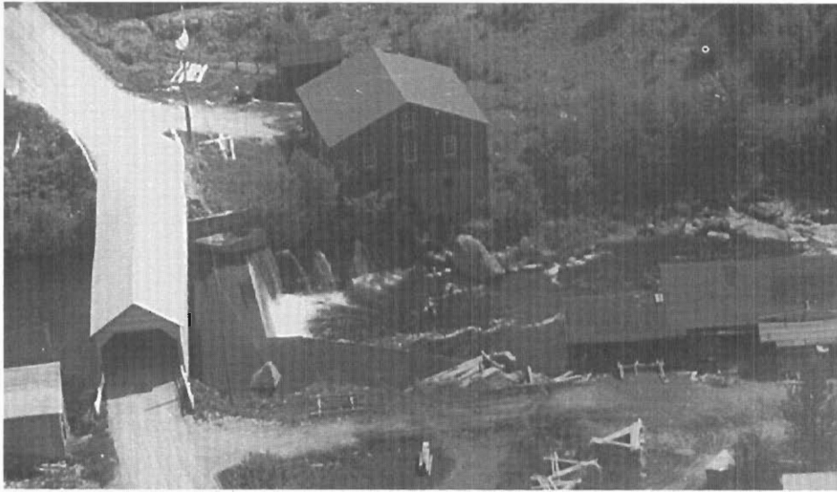
Vue du pont couvert. Au centre, manufacture d'Omer Tottier. À droite, moulin à scie de Bertrand Trottier.
