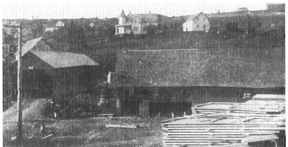
Moulin d'Amédée Trottier. Le bâtiment sera détruit par le feu, en 1939.
