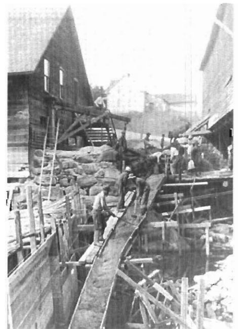
Construction du barrage en ciment, vers 1933.
