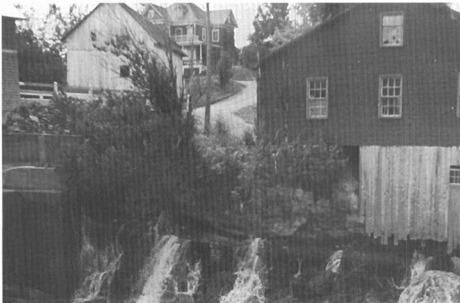
La maison et la grange d'Omer Trottier, ainsi que sa manufacture reconstruite après l'incendie de 1946.
