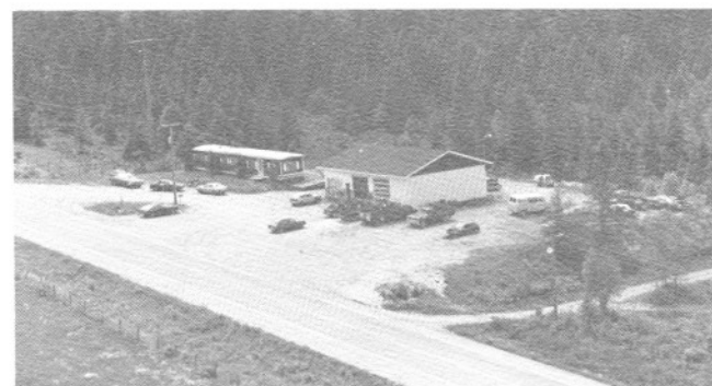
Garage de Michel Tardif, construit en 1976, sur la route 161, Ham-Nord.
