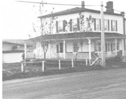
Maison sise au 290, 2 ième avenue, Ham-Nord.
