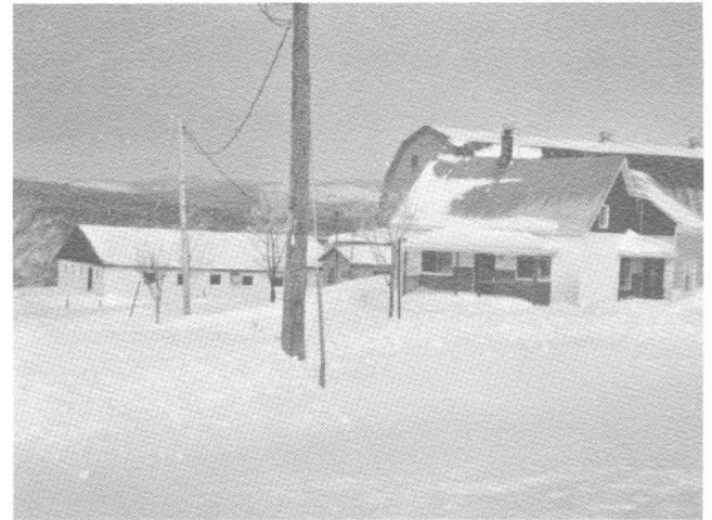
En 1986, construction de la vacherie.
