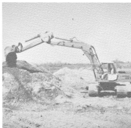
Pelle hydraulique pour sortir le gravier.
