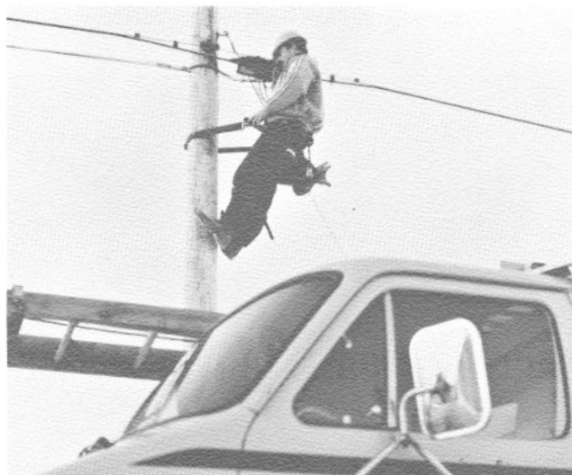
Pour le réseau aérien, l'escalade d'un poteau devient nécessaire.
