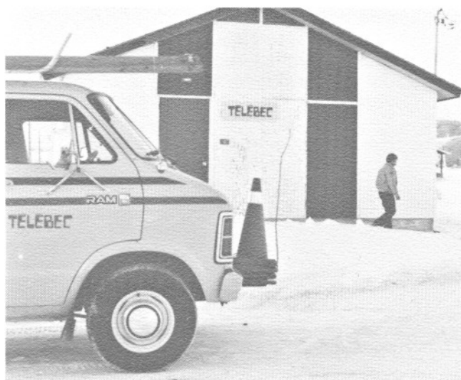
Vue extérieure du central Télébec.
