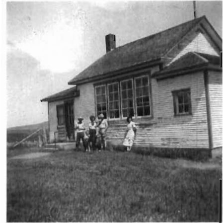
Fig. 112 – La maison-école avant son agrandissement
