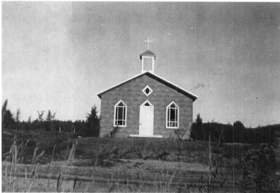
Fig. 110 – A : L'église vue de face. Noter l'abaissement de la route en 1952. L'élévation du chemin explique que le cimetière actuel soit plus en contre-bas de la route. (Source : A. Auberson)
