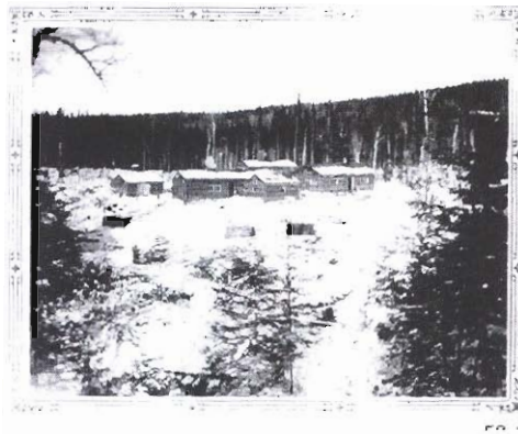
CHANTIER DE BÛCHERONS AU DÉBUT DES ANNÉES 1940
