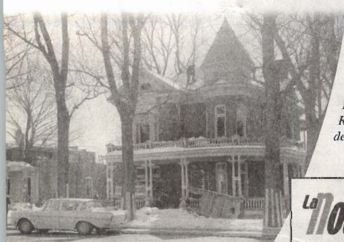
Démolition de la maison J.D. Gagné pour faire place au Steinberg
