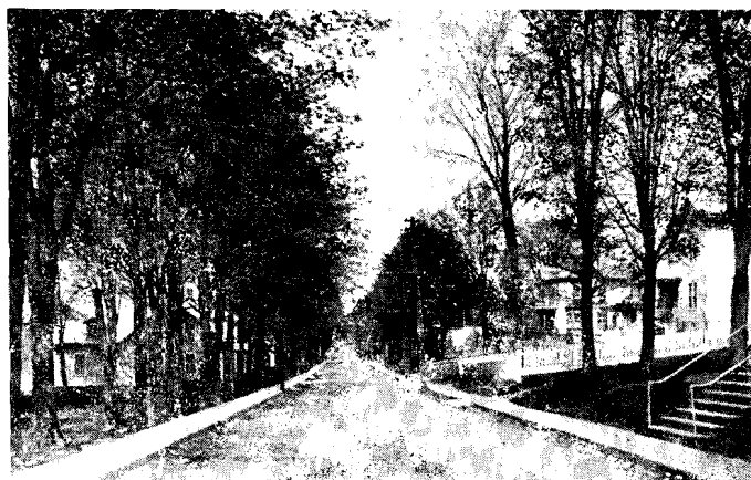
Vue de l'Avenue Laurier, regardant vers le Nord
