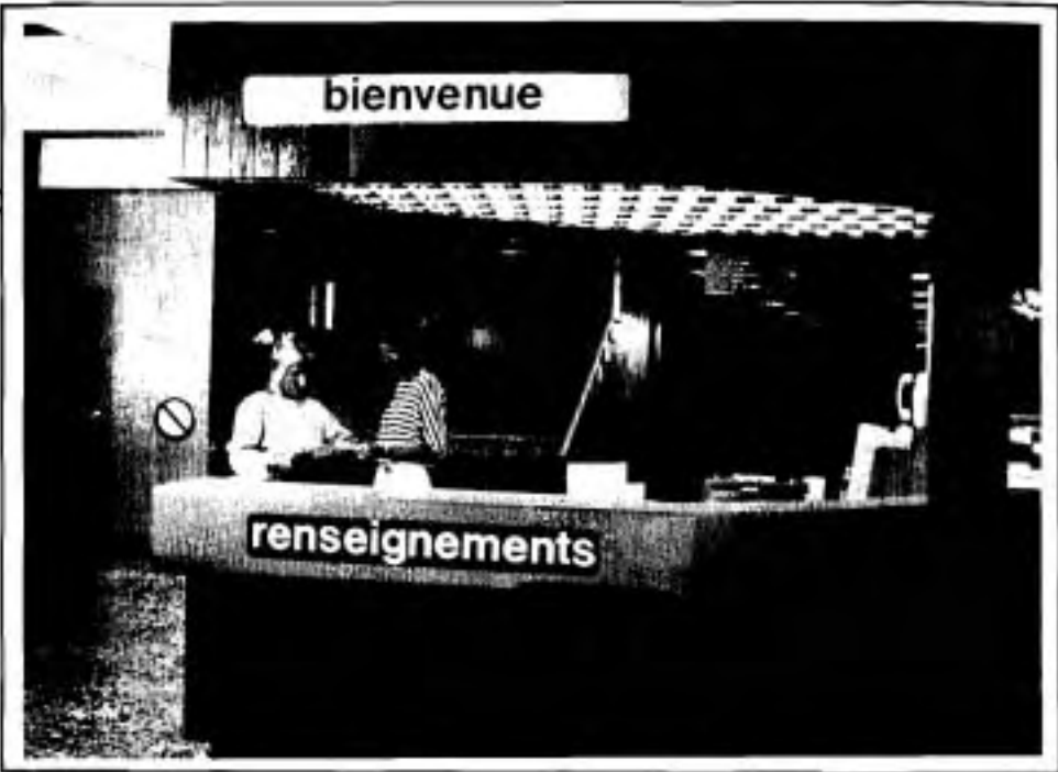
Rénovation du hall de l'entrée principale, mars 1983. On y voit le poste central des renseignements.
