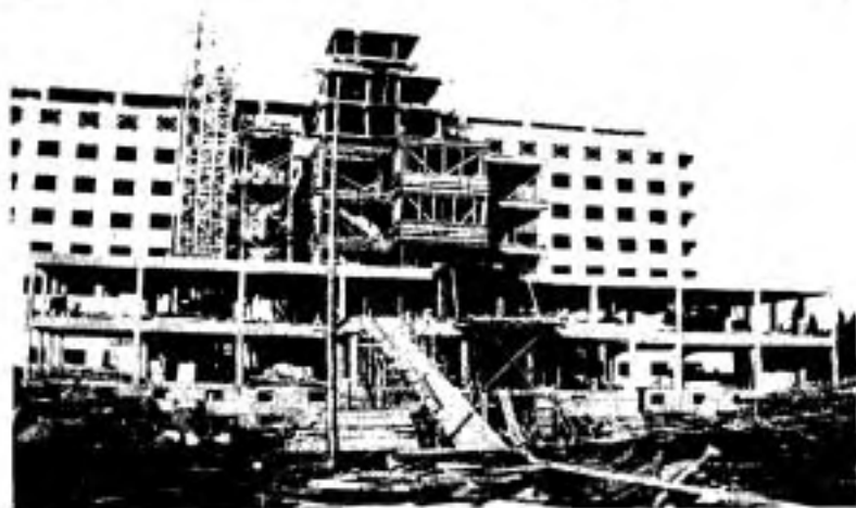
Le chantier de construction en 1948.
