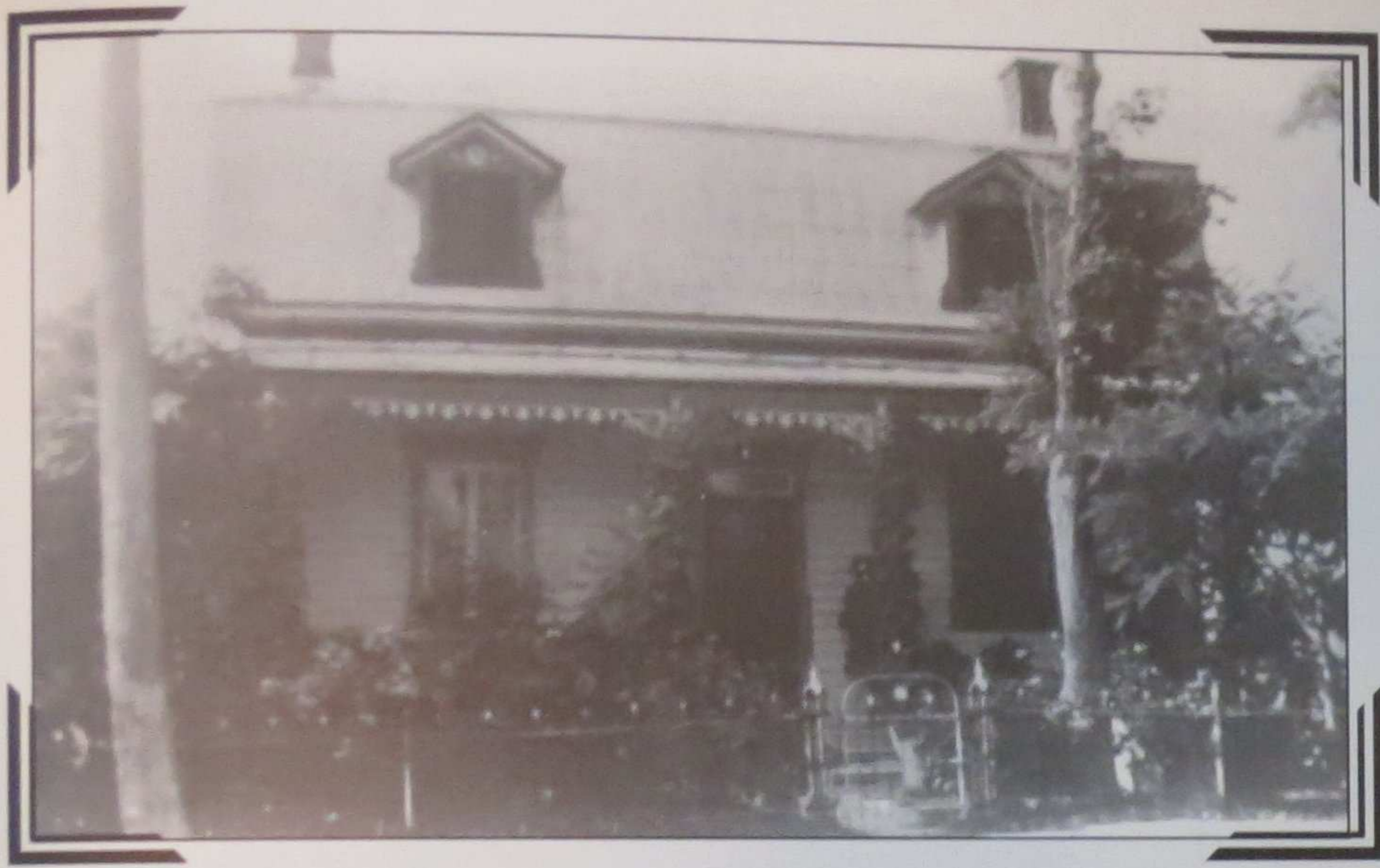
La maison aurait été construite vers la fin des années 1800. (Photo 1926)
