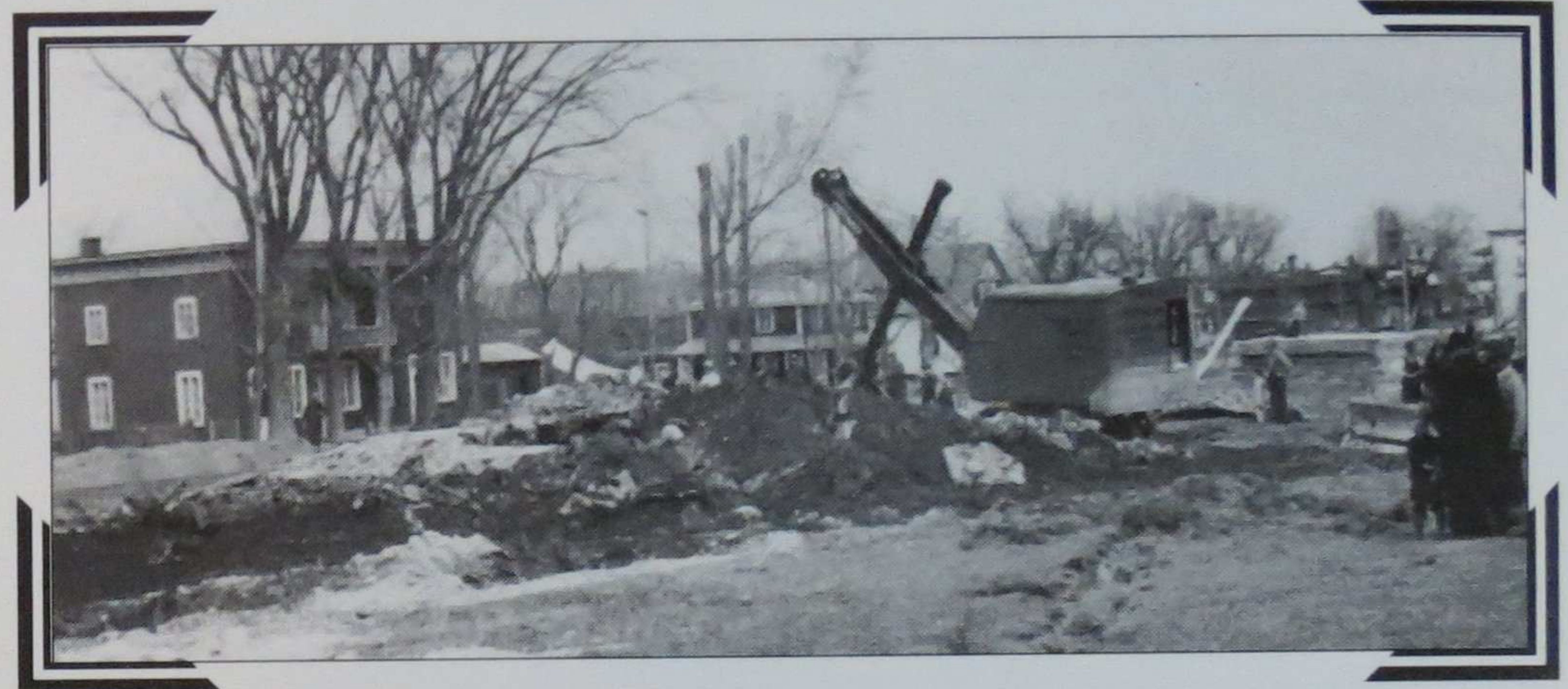
1946 - A gauche, magasin général des Gaboriau qui fut vendu plus tard à Paul Giraldeau et Cécile Boileau puis devint la boucherie de Louis-George et Réjean Rozon. Ce bâtiment abrite maintenant le Café Europe.
