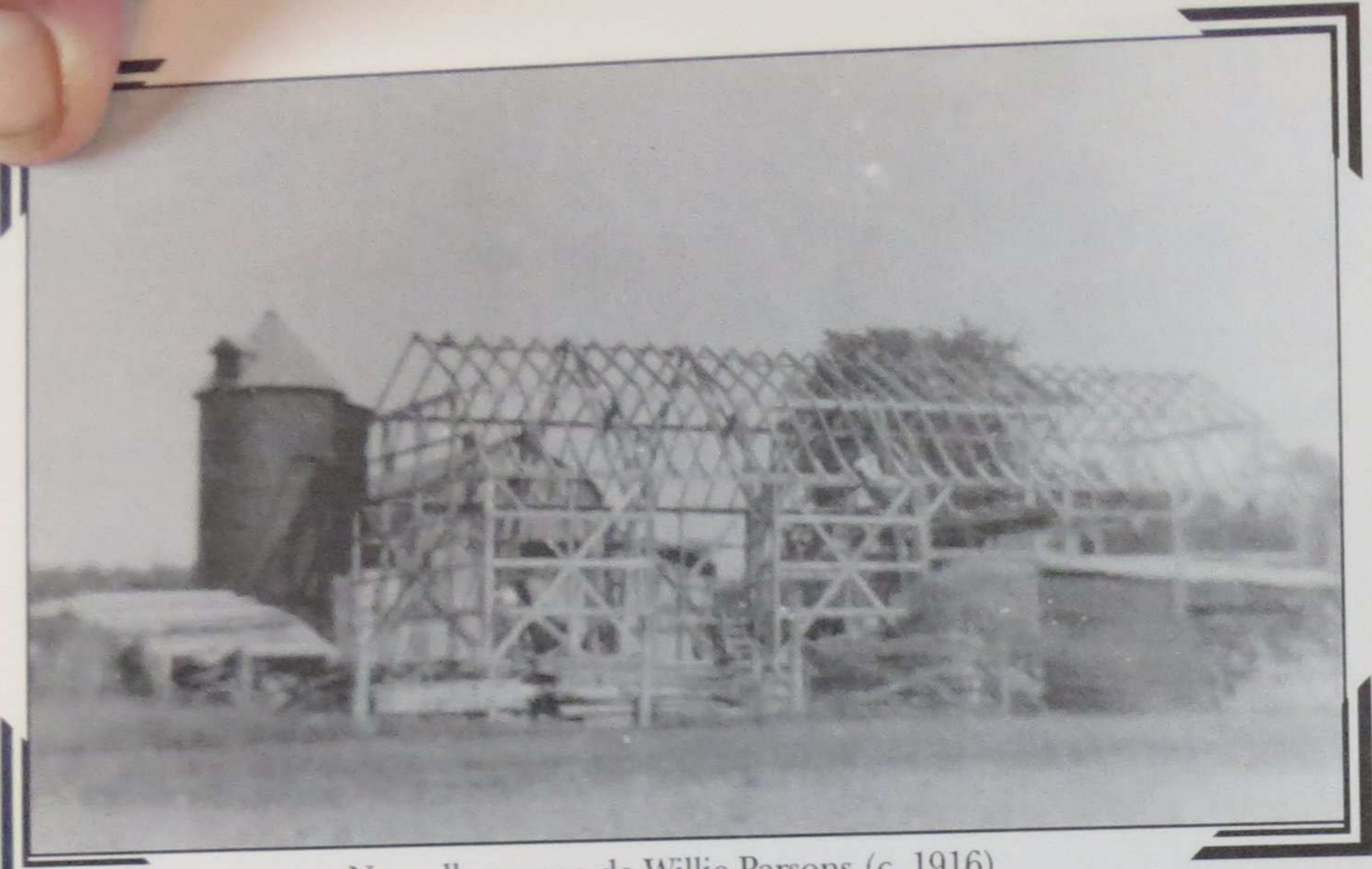
Nouvelle grange de Willie Parsons (c. 1916). Démolie dans les années 60, elle se trouvait sur le terrain du restaurant Mon village.
