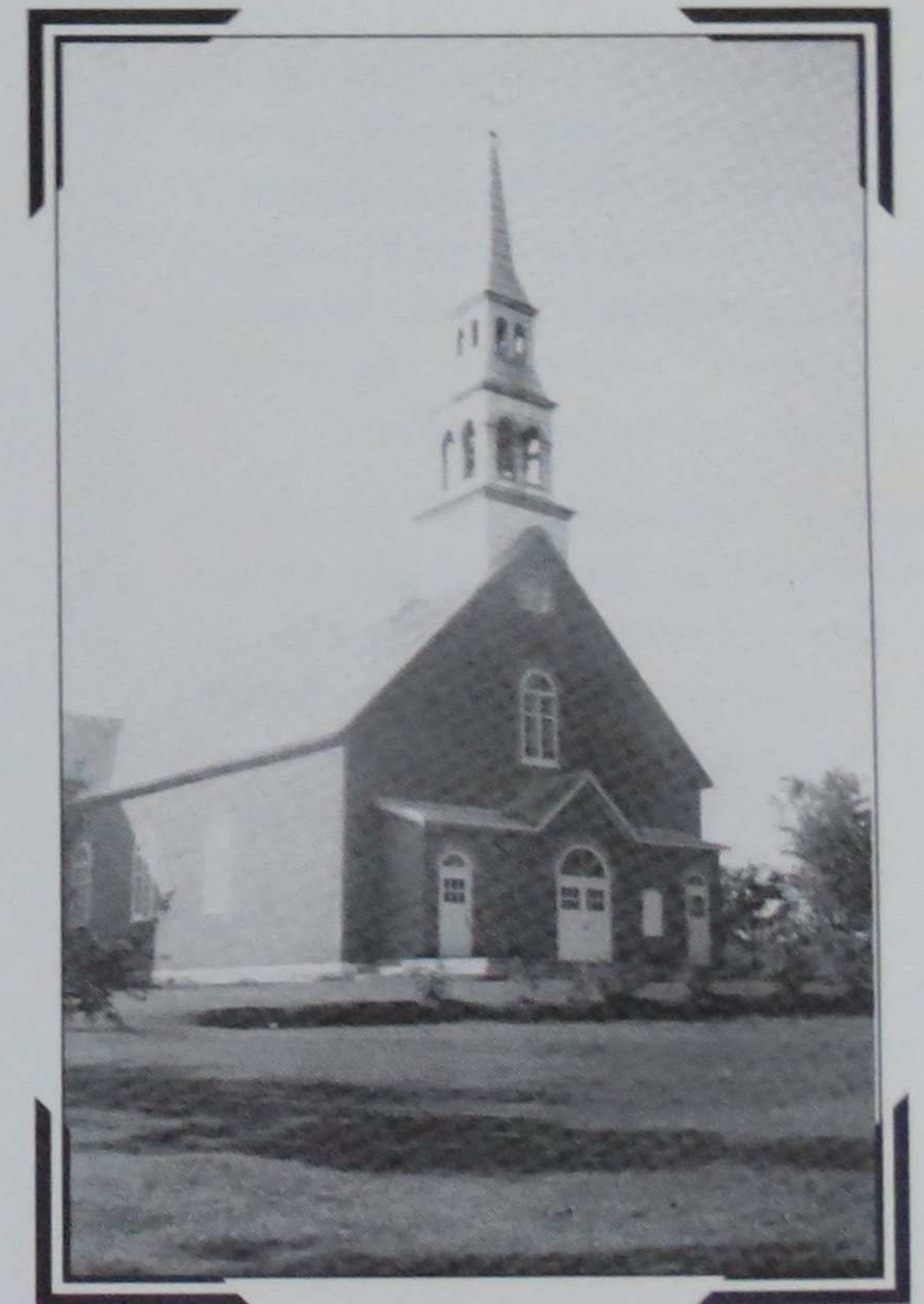
Première église, rénovée Newly renovated church, 1921
